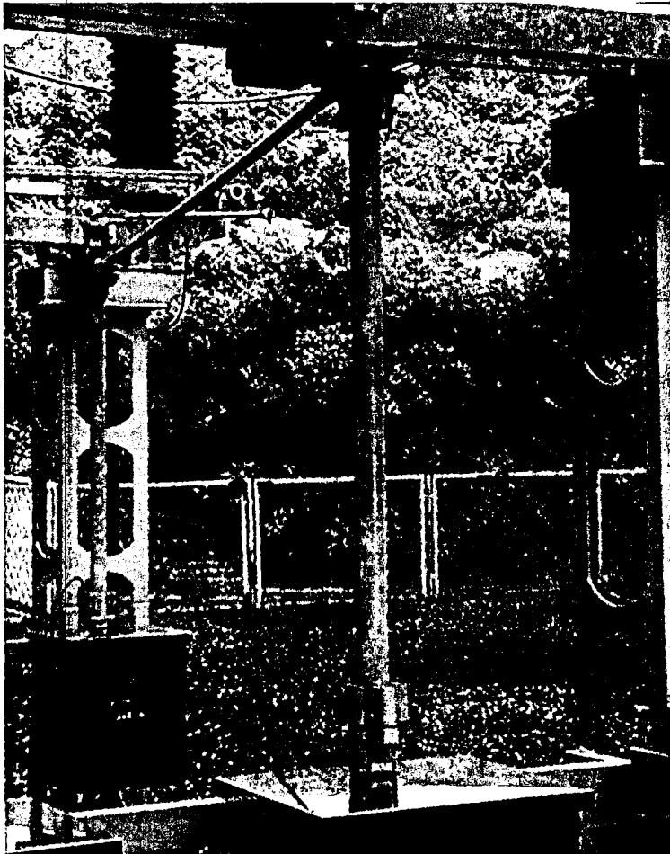
Слика бр.13: Механичка међублокада_између два моторна погона
