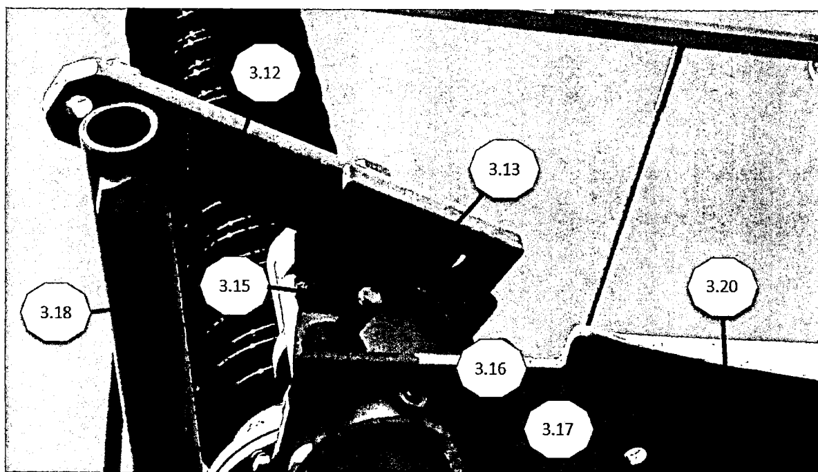
Слика бр.8: Веза моторног погона и растављача (деталј повезивања вратила Моторног погона и управљачке спојне полуге растављача) Picture 8: Connection between motor drive and disconnect mechanism (detail of motor drive vertical drive shaft connection to the control linkage of the disconnect)
